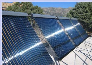
Por su forma cilíndrica, aprovechan la radiación de manera más efectiva que los colectores planos, al permitir que los rayos de sol incidan de forma perpendicular sobre los tubos durante la mayor parte del día. Estos colectores son hasta un 30% más eficiente que los colectores planos, pero son más costosos.
